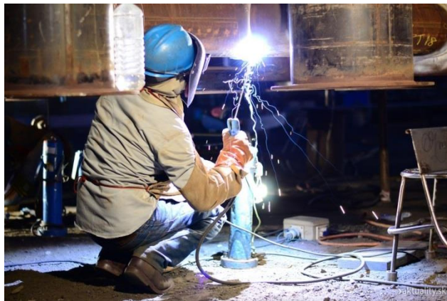
Obrázok 1 : Pracovník vystavený UV žiareniu z elektrického oblúka na zváranie Zdroj : http://www.sjf.tuke.sk/inmf/NW/Original/Web/roz.php
